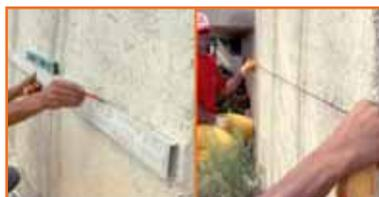
Перед монтажом крайне важно проверить несущие свойства фасадной стены – она должна быть сухой и ровной. Это проверяется с помощью отвеса, веревки и уровня (ватерпаса). Если обнаружатся неровности, отслоения и прочие дефекты, перед монтажом поверхность стены необходимо заштукатурить, при этом неровности стены не должны превышать  $\pm 10$  мм на 1 м<sup>2</sup>.
