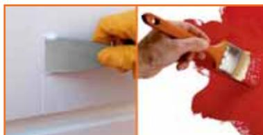
Когда шпатлёвка высохнет, стыки следует отшлифовать шкуркой. После того как все места стыковки изосайдинга, лепного декора и крепления дюбелей высохли и зашлифованы, изосайдинг легко грунтуется водной грунтовкой и красится силиконовыми или акриловыми фасадными красками на водной основе (краски не должны содержать растворитель или ацетон).
