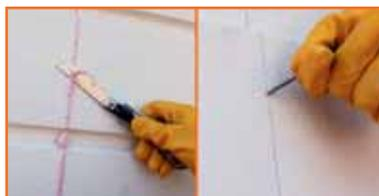
В местах соединения панелей макетным ножом срежьте излишки высохшей пены, слева и справа необходимо вырезать фаску глубиной от 2 до 5 мм. Затем эти швы-стыки зашпаклюйте шпатлёвкой CMC Izolasyon, как и отверстия от дюбелей. После высыхания шпатлёвки эти места шлифуются тонкой шкуркой. Соединения изосайдинга и лепного декора также необходимо зашпаклевать.
