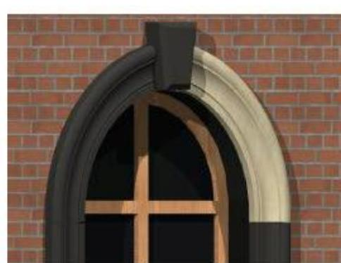
Радиусный элемент наличника - это профиль наличника, который вытянут по какому-либо радиусу. Такой элемент применяется на радиусных частях окон и дверей.
